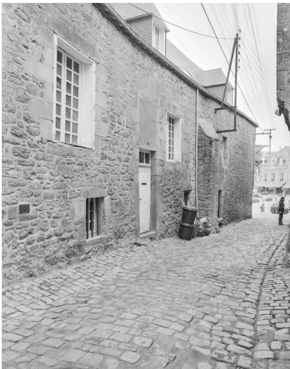
Vue générale de l'élévation latérale sur la rue du Petit Port
