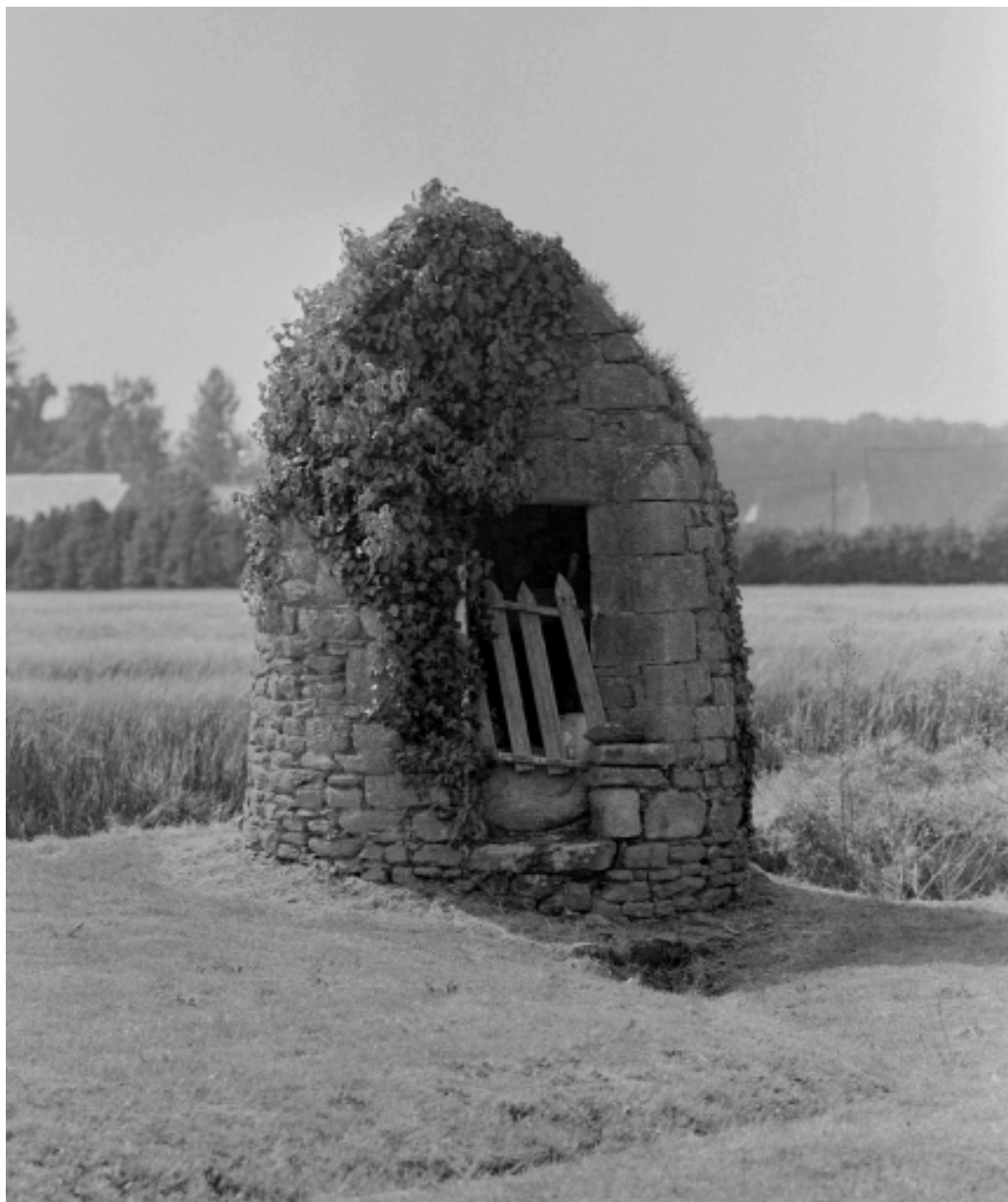
La basse-cour, puits : face antérieure
