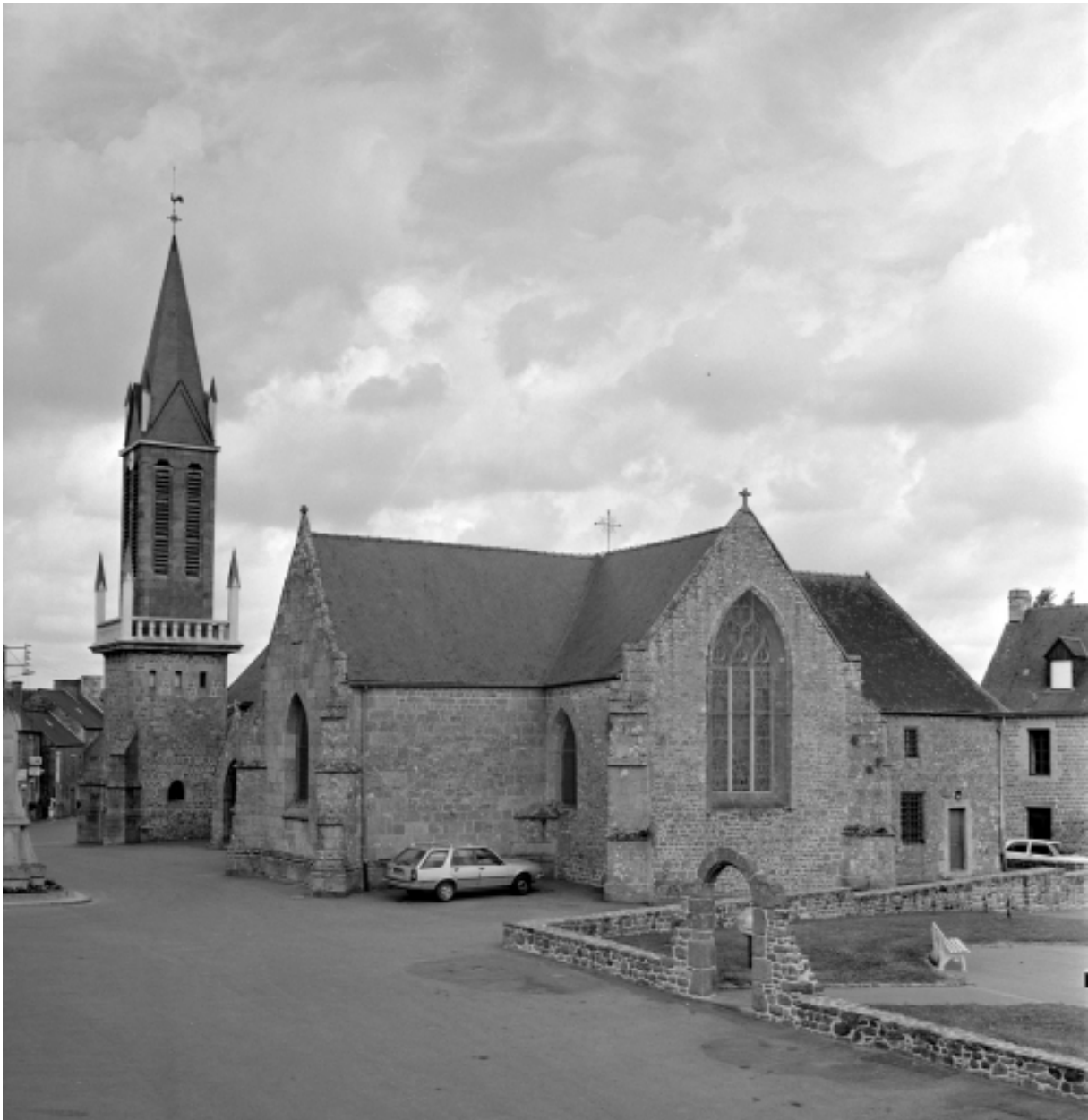
Elévation Sud-Est : vue générale
