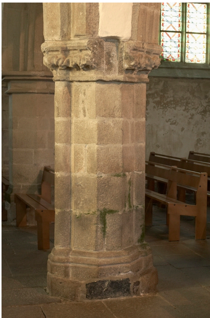
Pile du collatéral sud au niveau du transept
