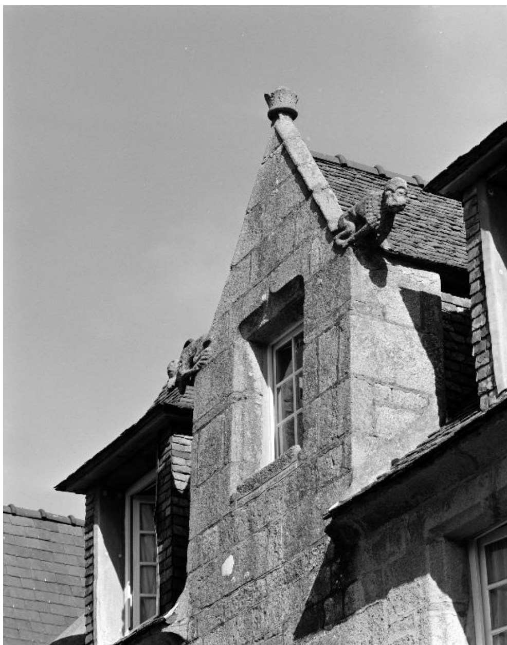
19 rue Armand Rousseau, élévation nord, détail d'une lucarne
