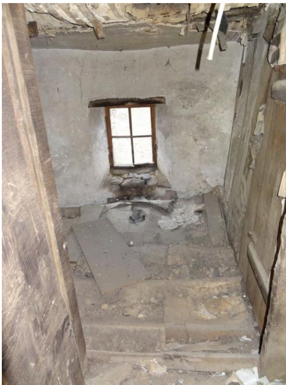
Jour d'éclairage donnant sur le comble
