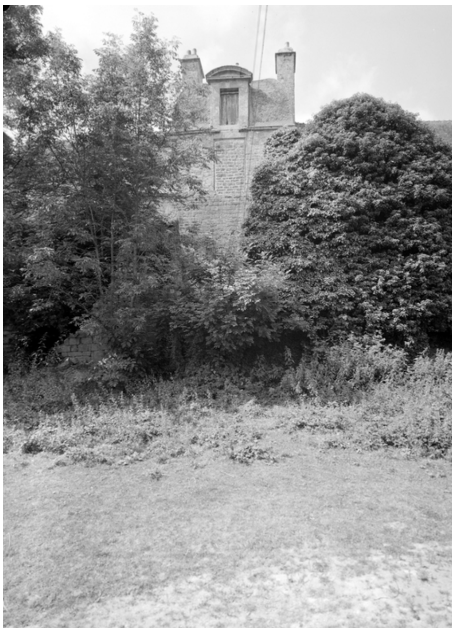
Façade nord, état en 1967
