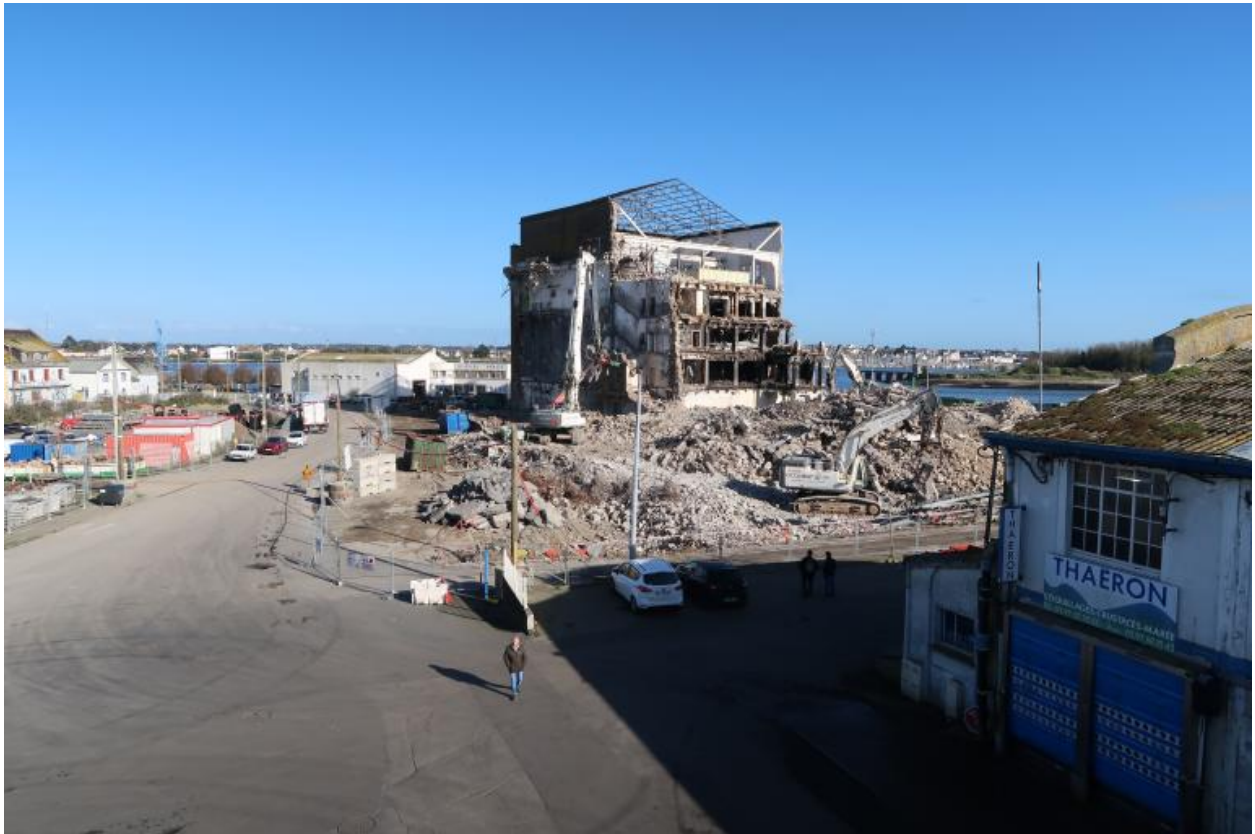
Déconstruction de l'ancien frigorifique, 10 mars 2022
