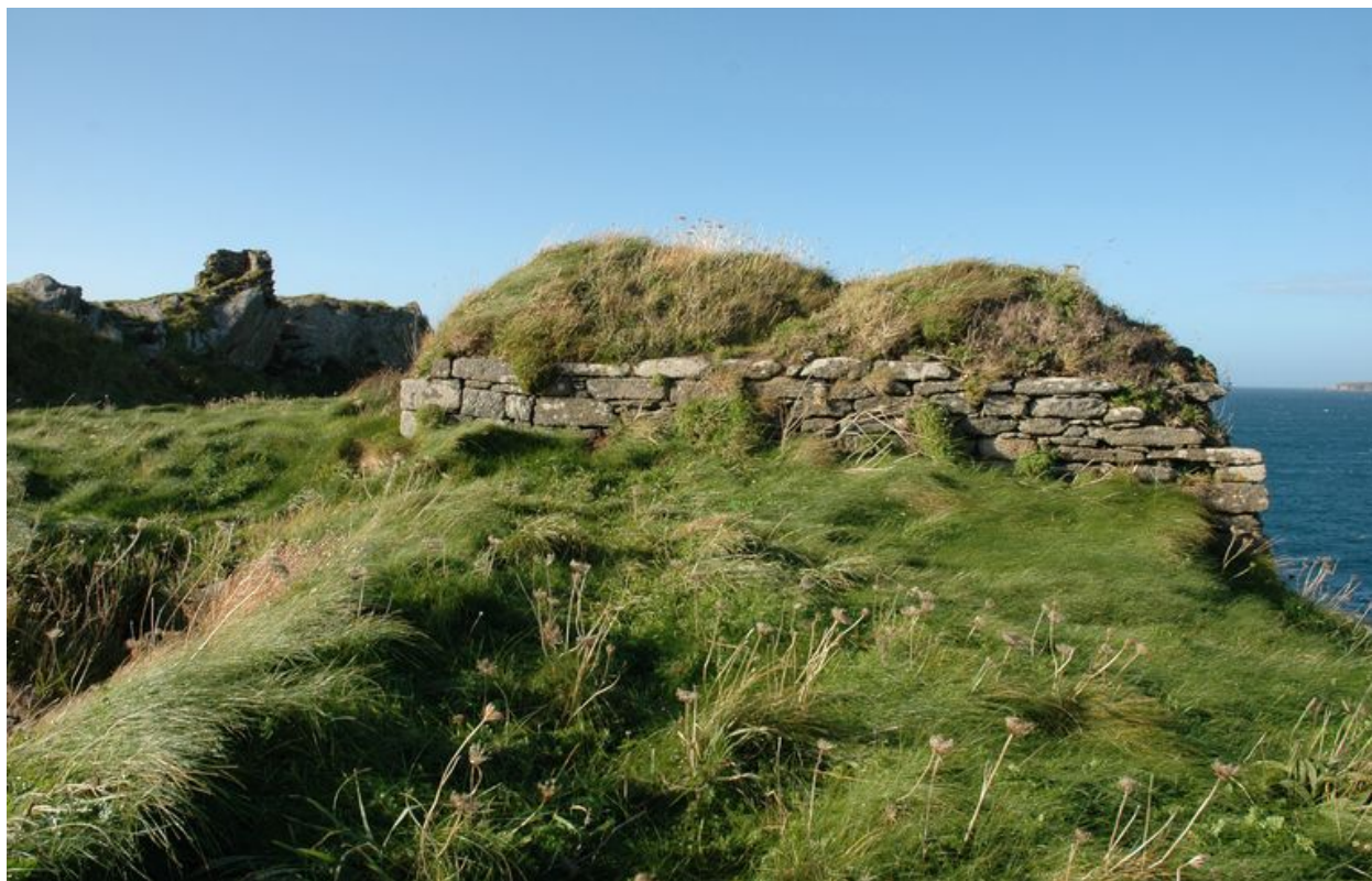
Vue du parapet de la batterie haute
