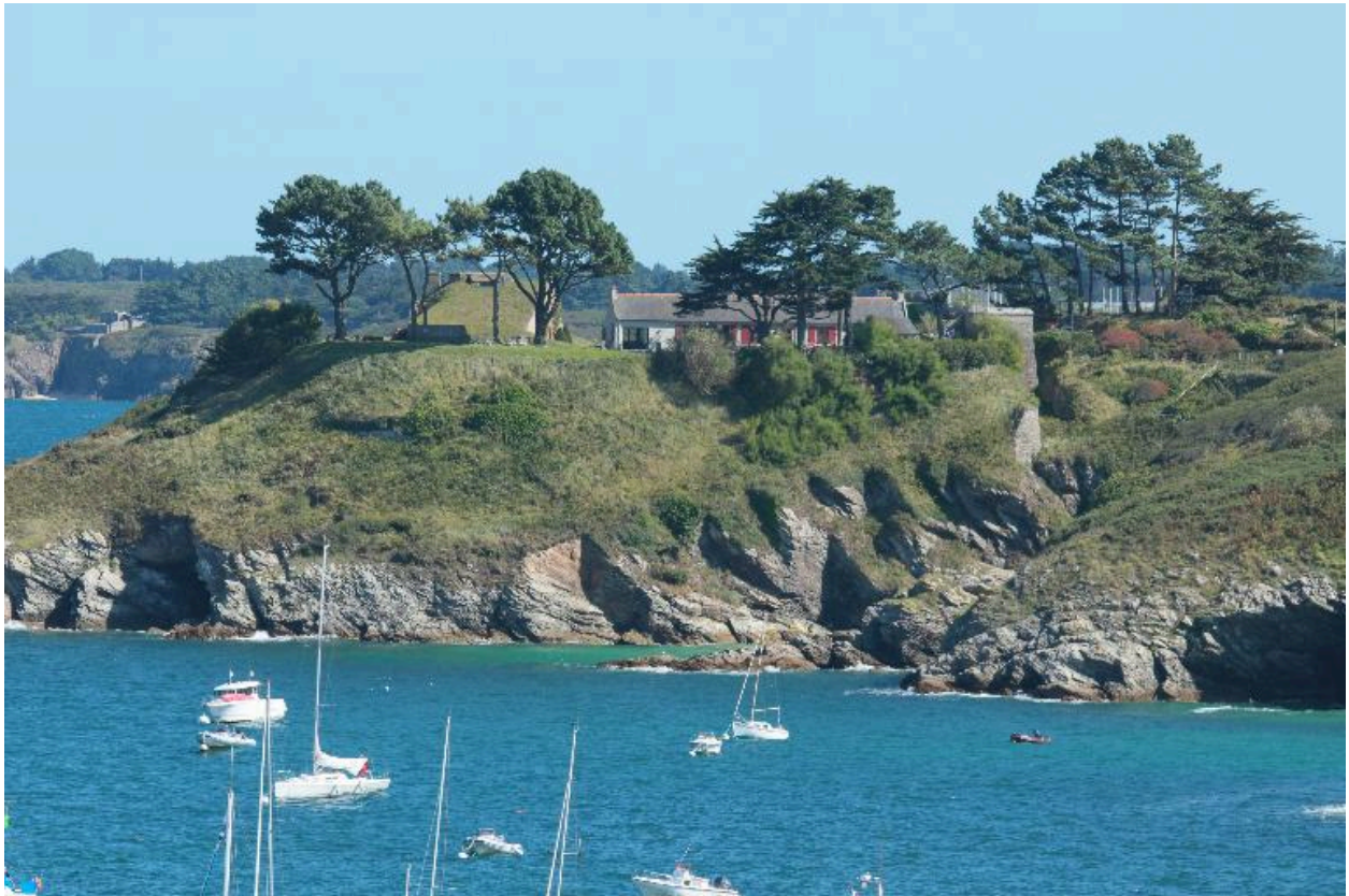
Le Palais, batterie de Ramonette, vue générale depuis le nord-ouest.
