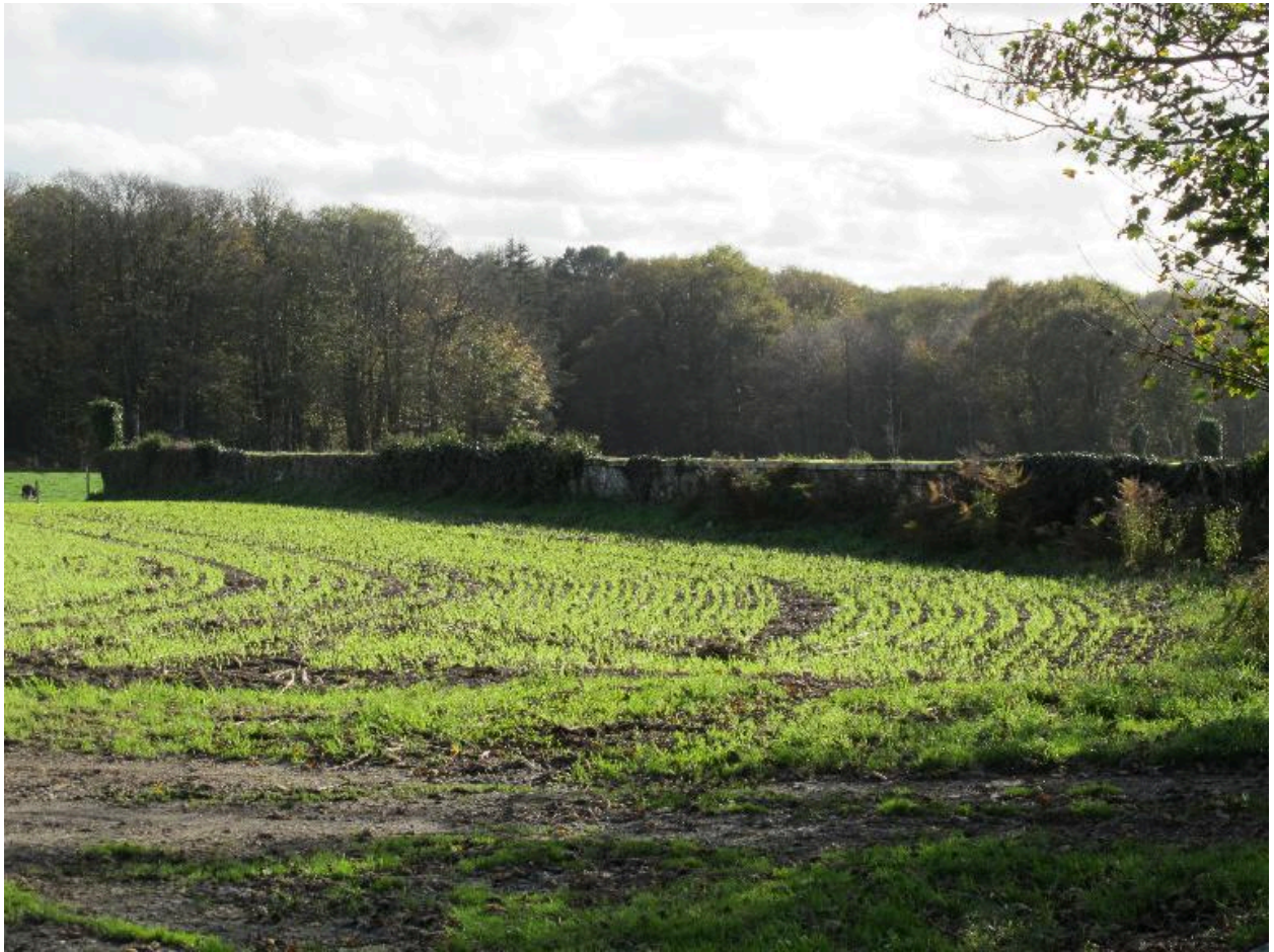
Enclos du parc du château, état en 2015
