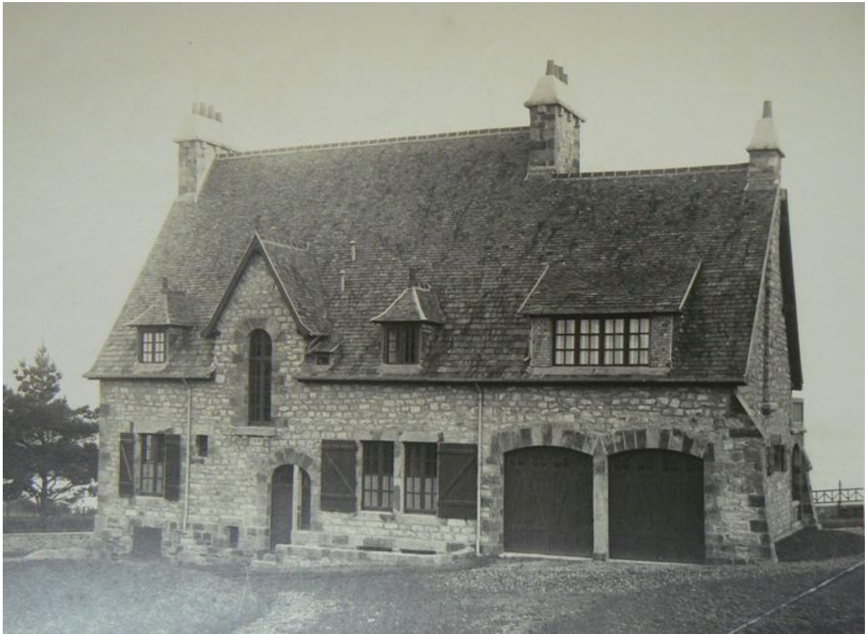
Vue ancienne de l'arrière de la villa Les Grottes, côté terre
