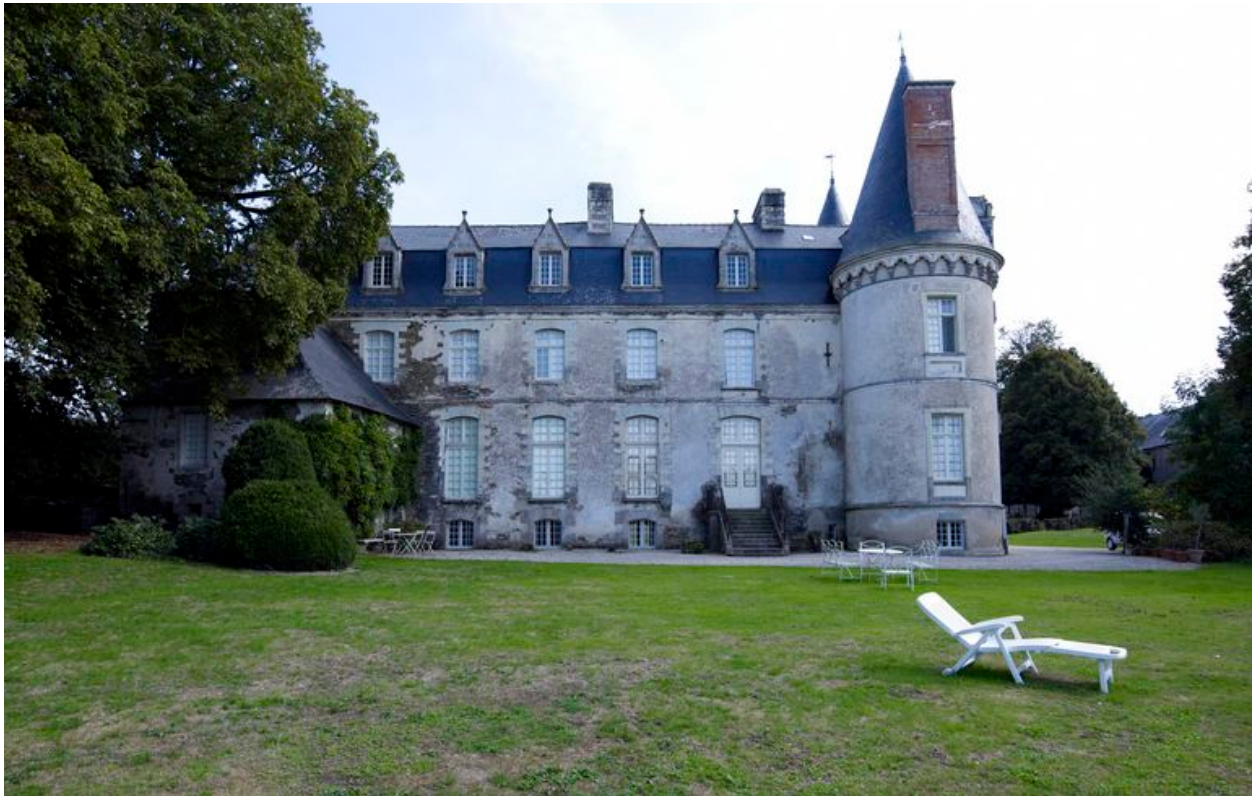
Château, logis, élévation nord : vue générale prise de l'ouest (état en 2010)
