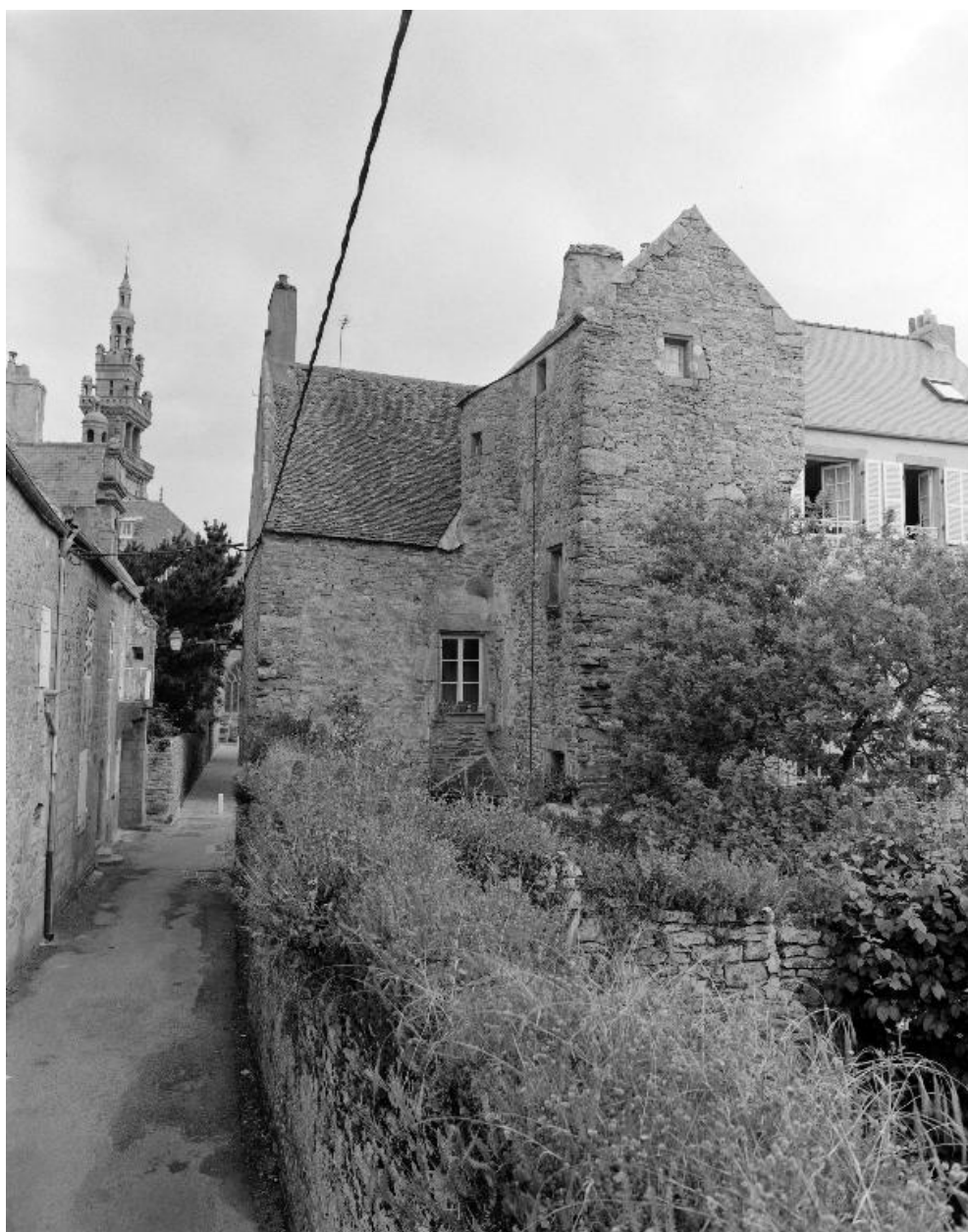
Elévation sud, vue générale
