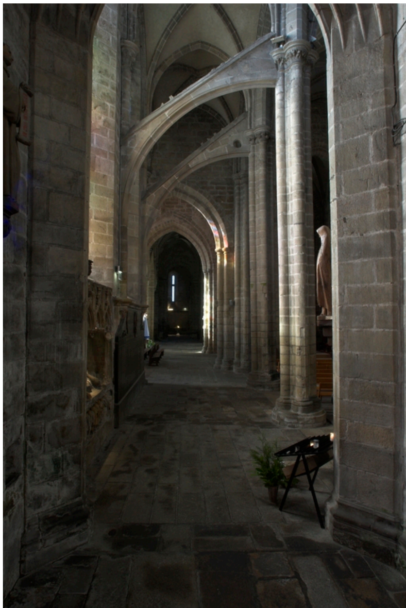
Collatéral sud du choeur, vue vers l'ouest
