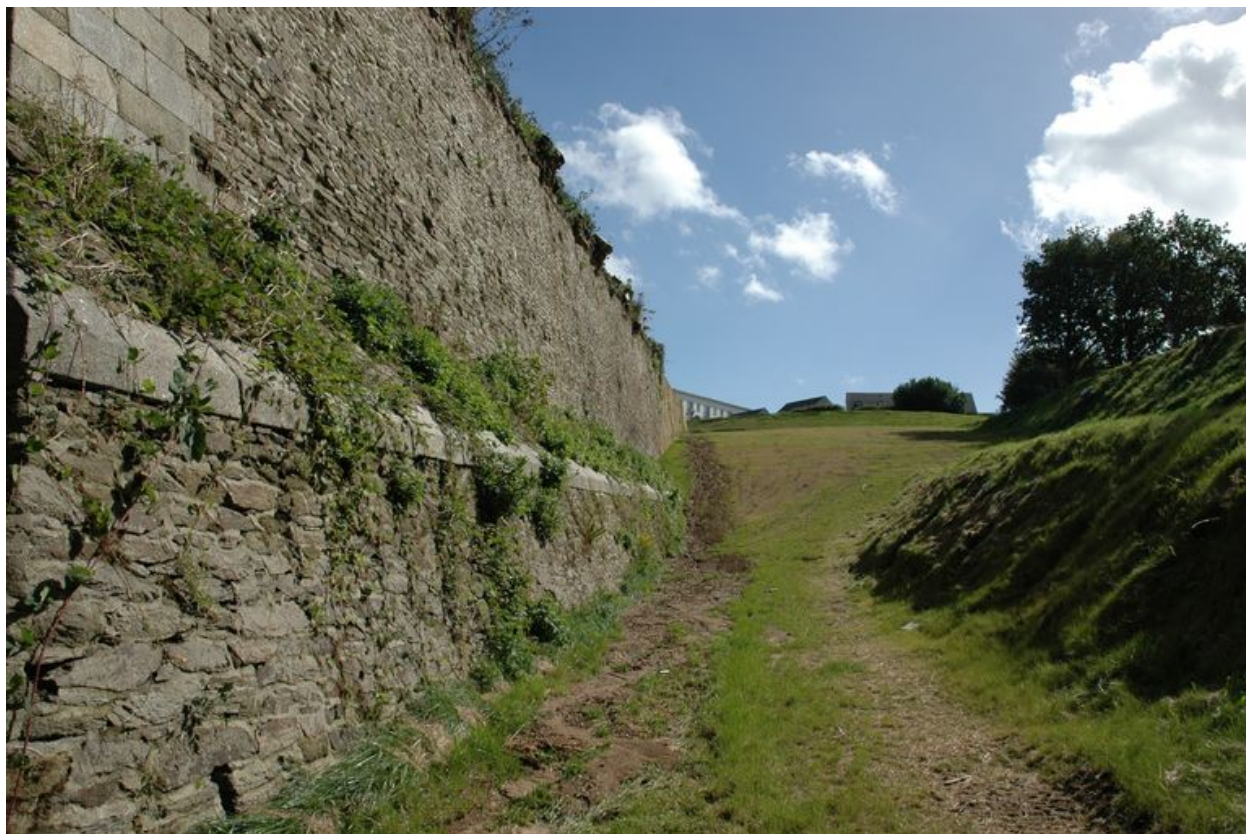
Vue de l'ouvrage à cornes de Quéliverzan
