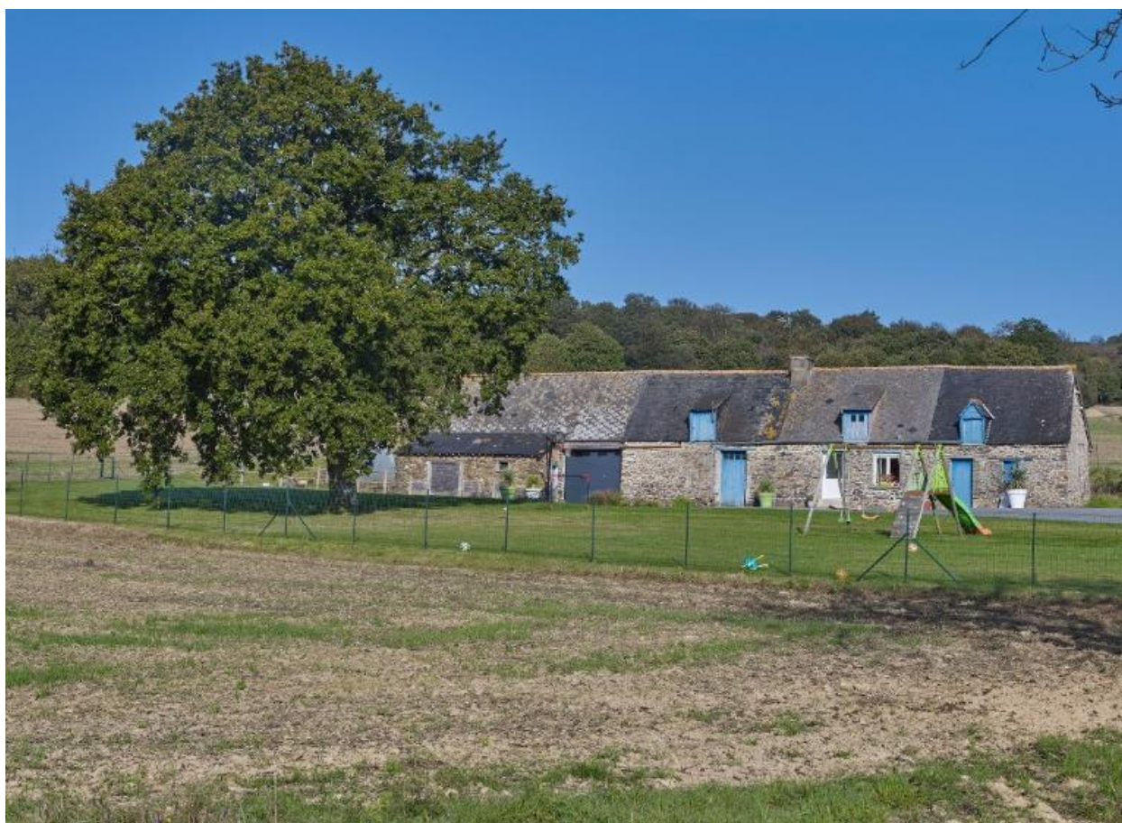
Alignement. Vue générale sud
