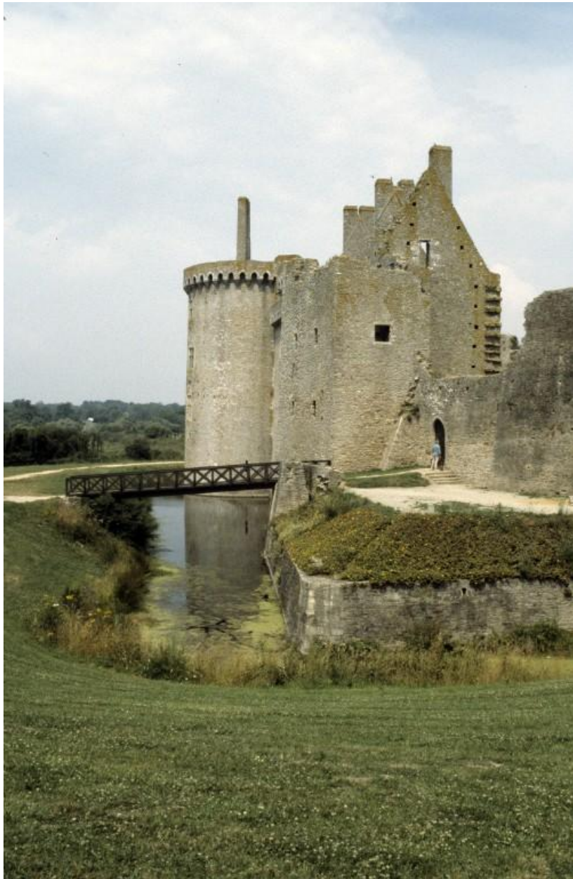
Château fort, logis ouest et bastion, vue sud.
