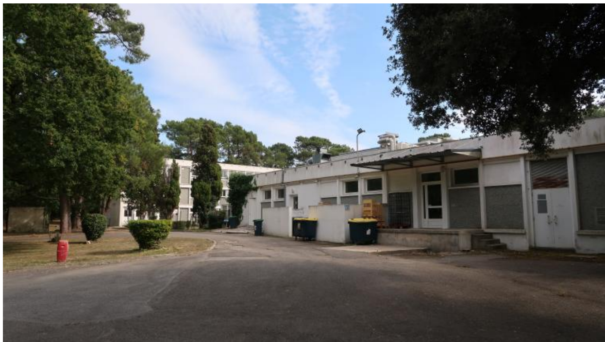
Cuisine et quai de livraison, façade nord. Yves Guillou, architecte, 1969.
