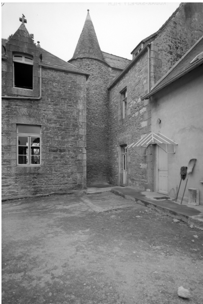
Tourelle d'angle sud-ouest du bâtiment
