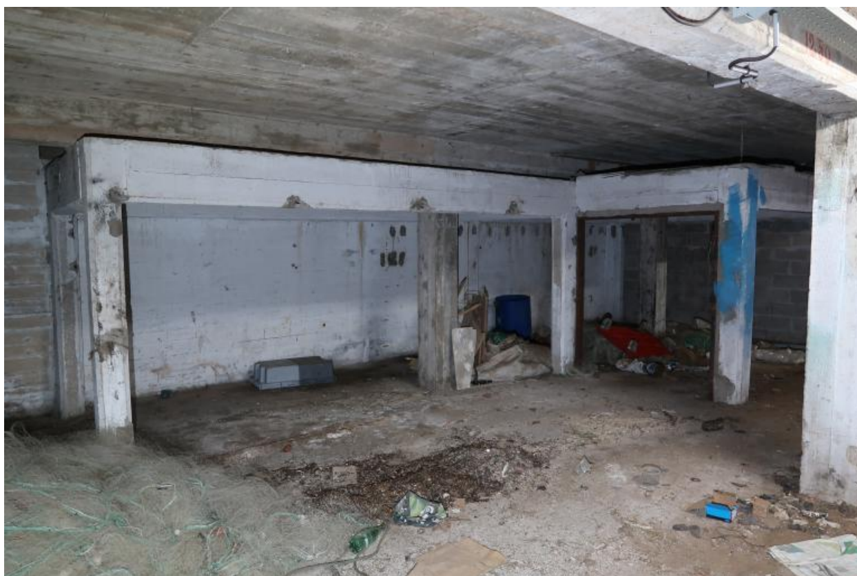
Rez-de-chaussée : extrémité sud (emplacement des ateliers)
