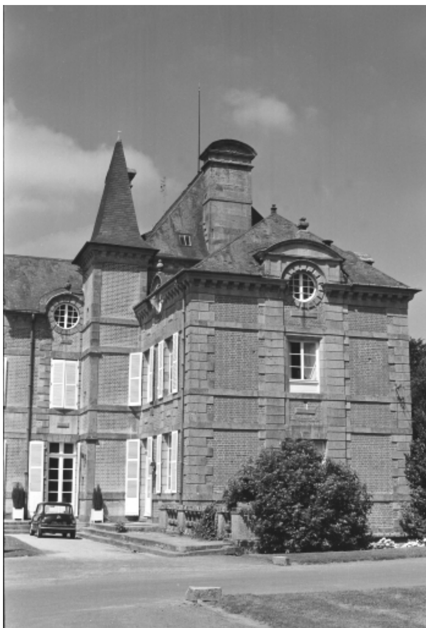
Aile ouest du château
