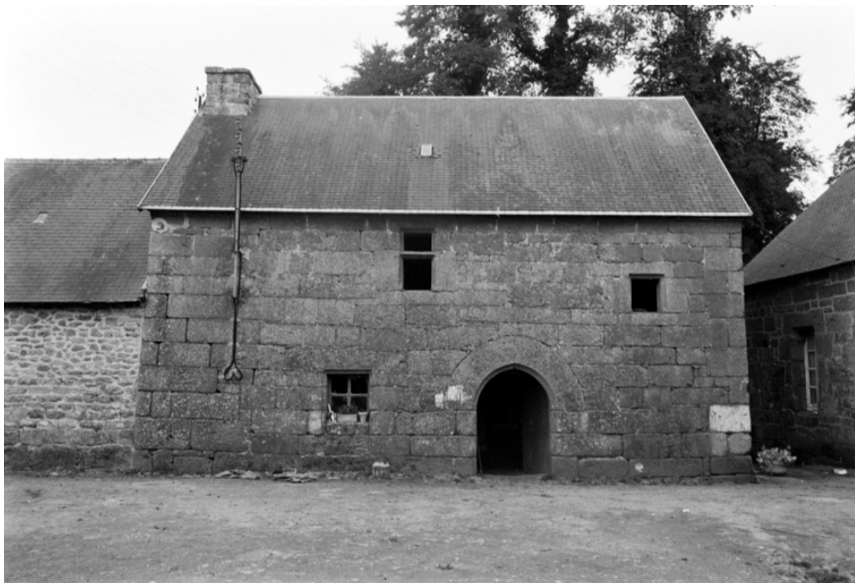
Maison de Carlouet : façade principale, vue générale
