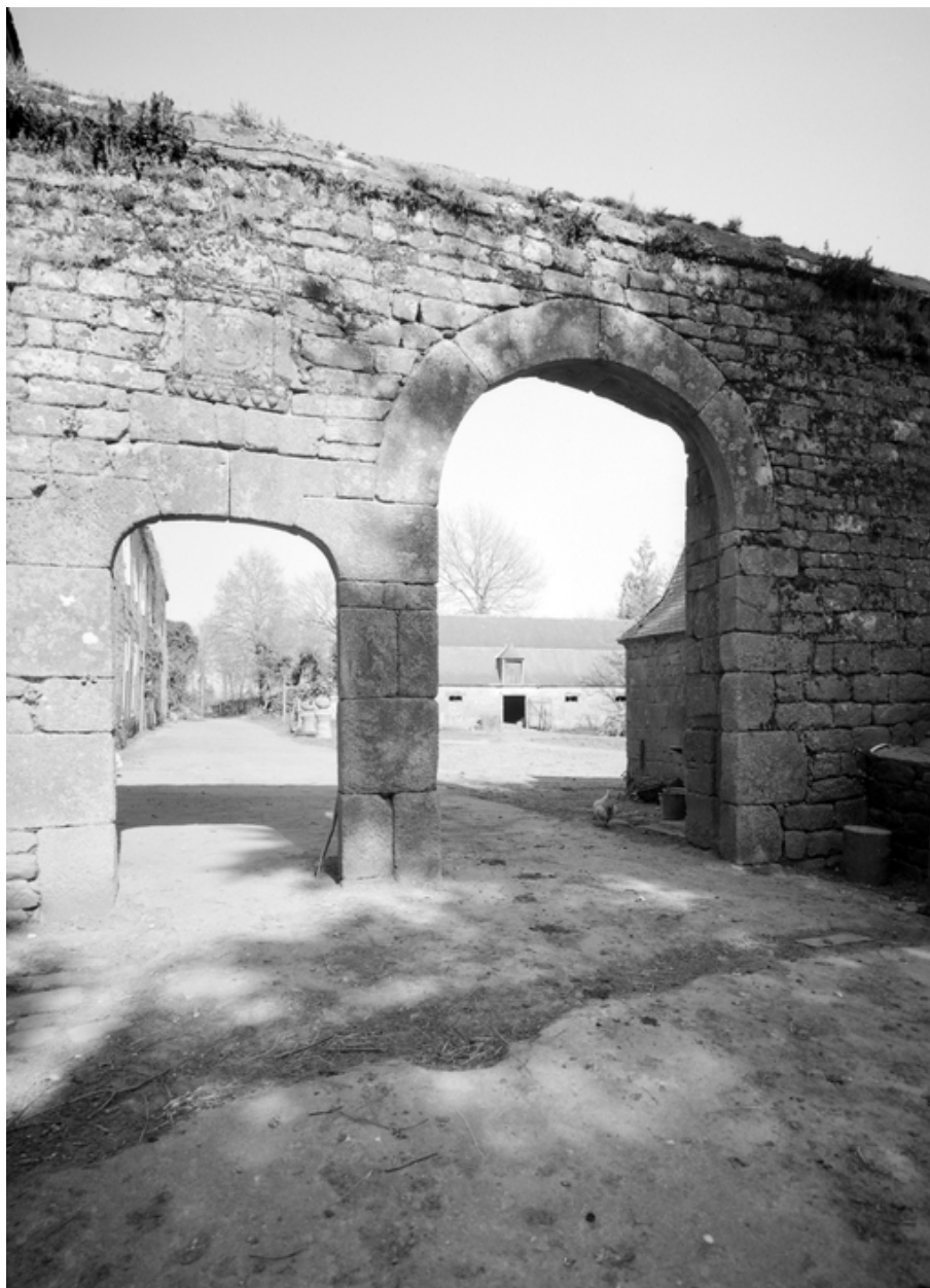
Vue d'ensemble du portail d'entrée
