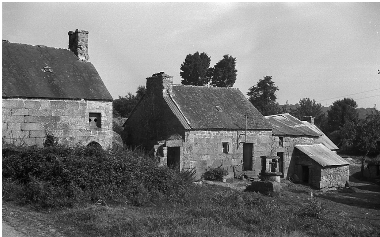
Ferme (Guillerbot) : vue générale de la façade sud ouest
