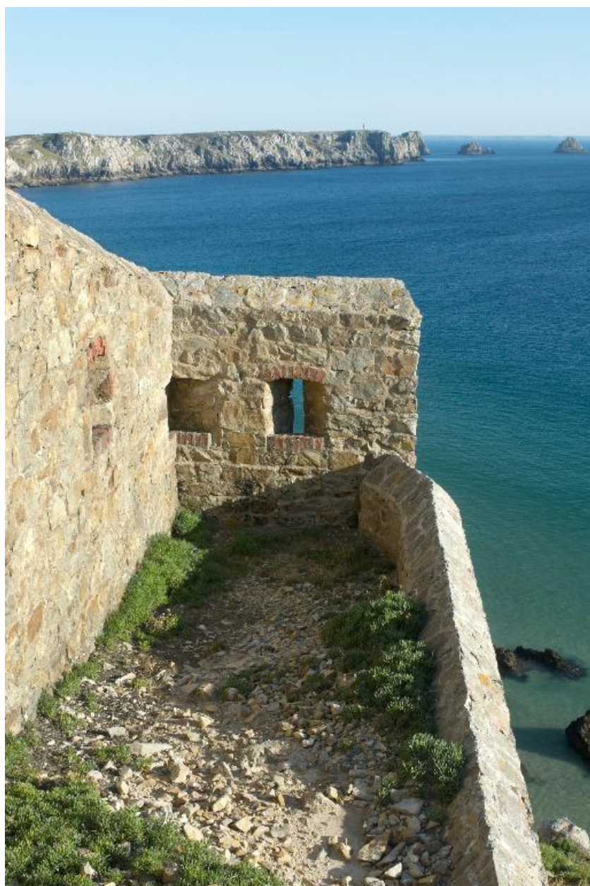
Camaret-sur-Mer, pointe du Toulinguet : vue du mur défensif percé de créneaux de fusillade. En arrière plan : la pointe de Pen Hir
