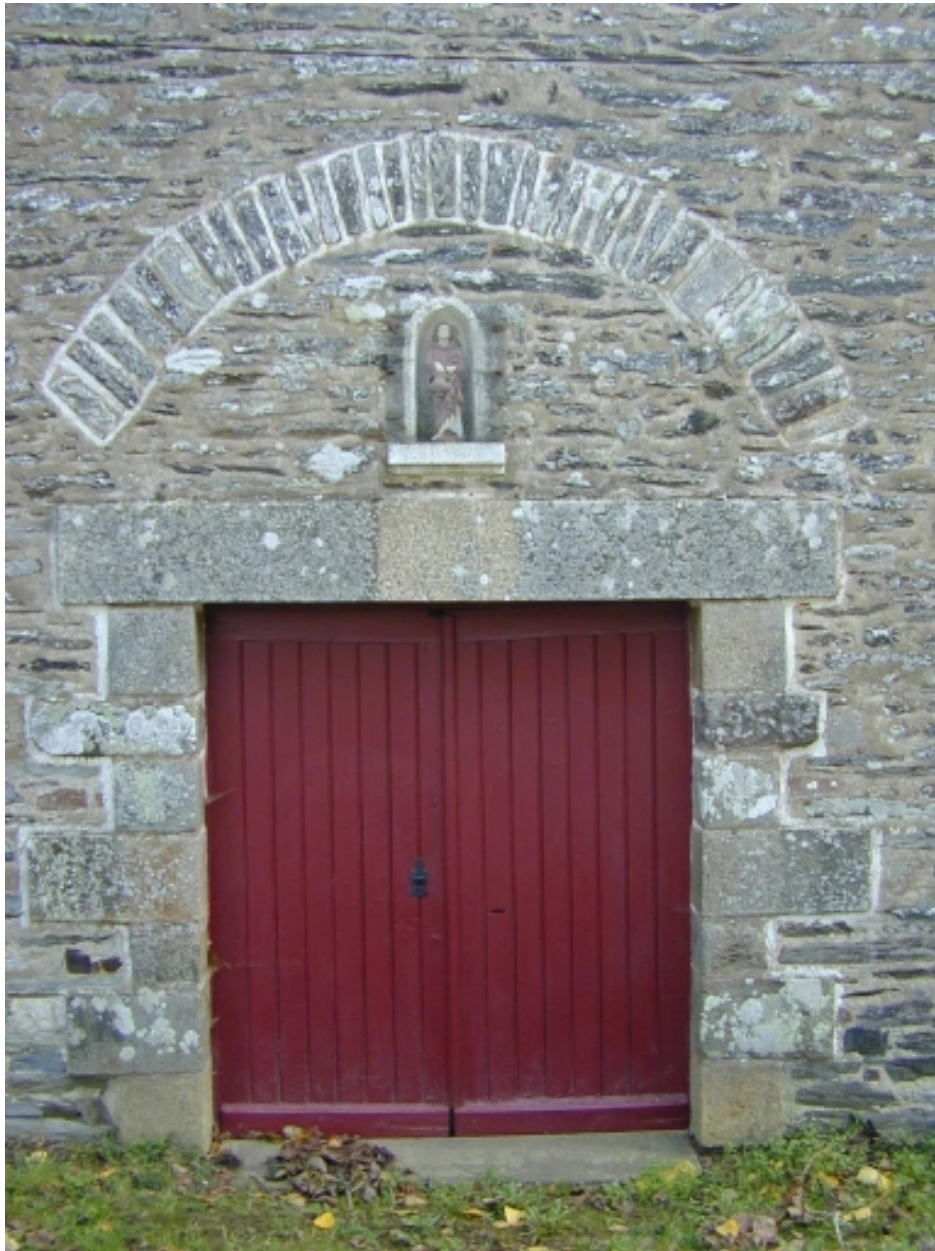
La porte occidentale : vue générale ouest
