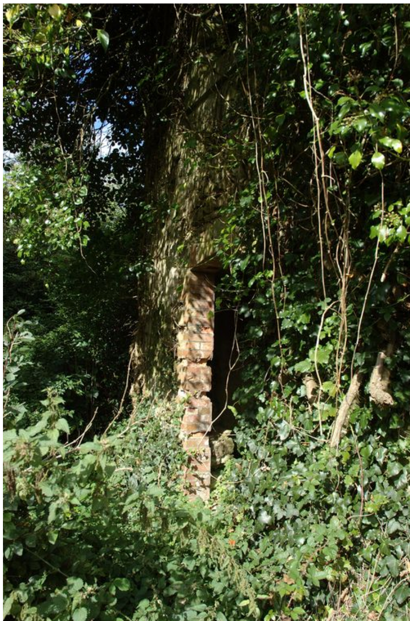
Vue de la caserne (état en 2007)
