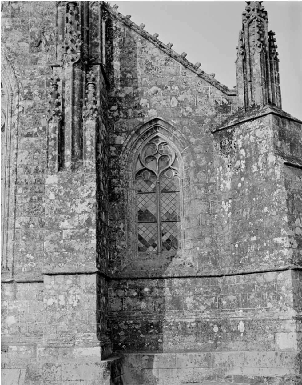
Façade est, détail de la fenêtre du bas-côté nord.
