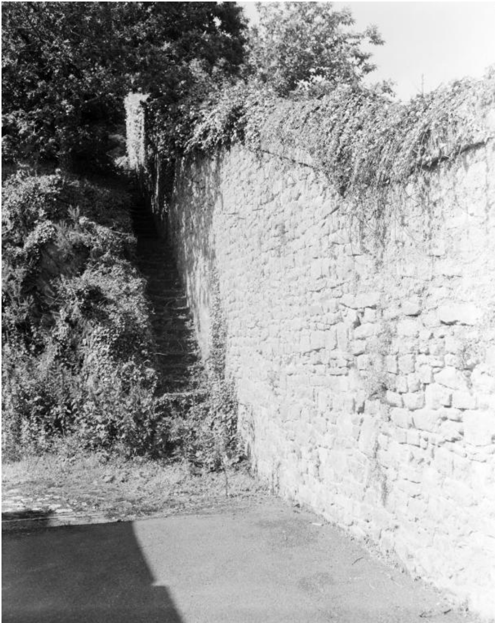
Magasin à poudre n° 1, escalier extérieur taillé dans le roc, vue du chemin de ronde (état en 1998)
