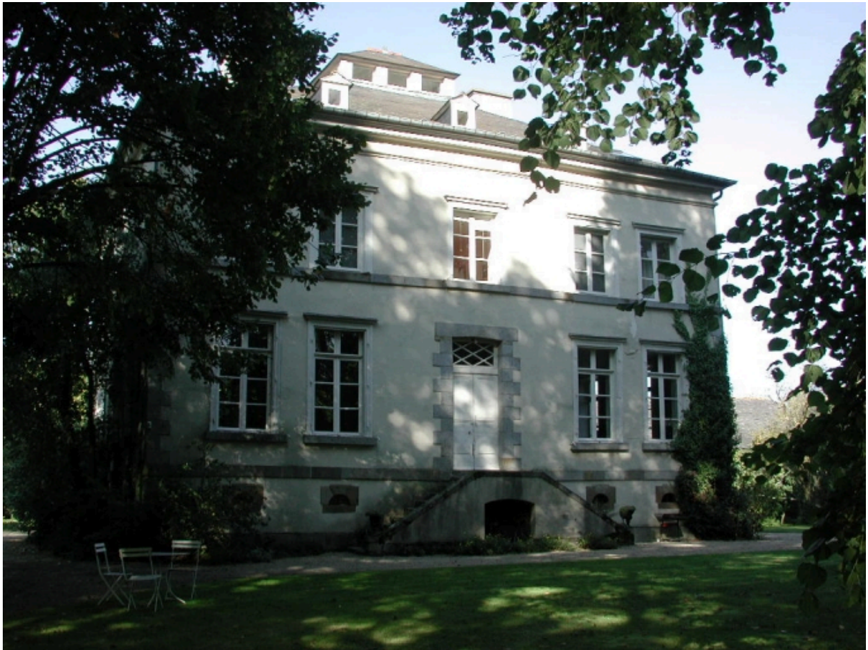
Vue générale de la façade sur le parc
