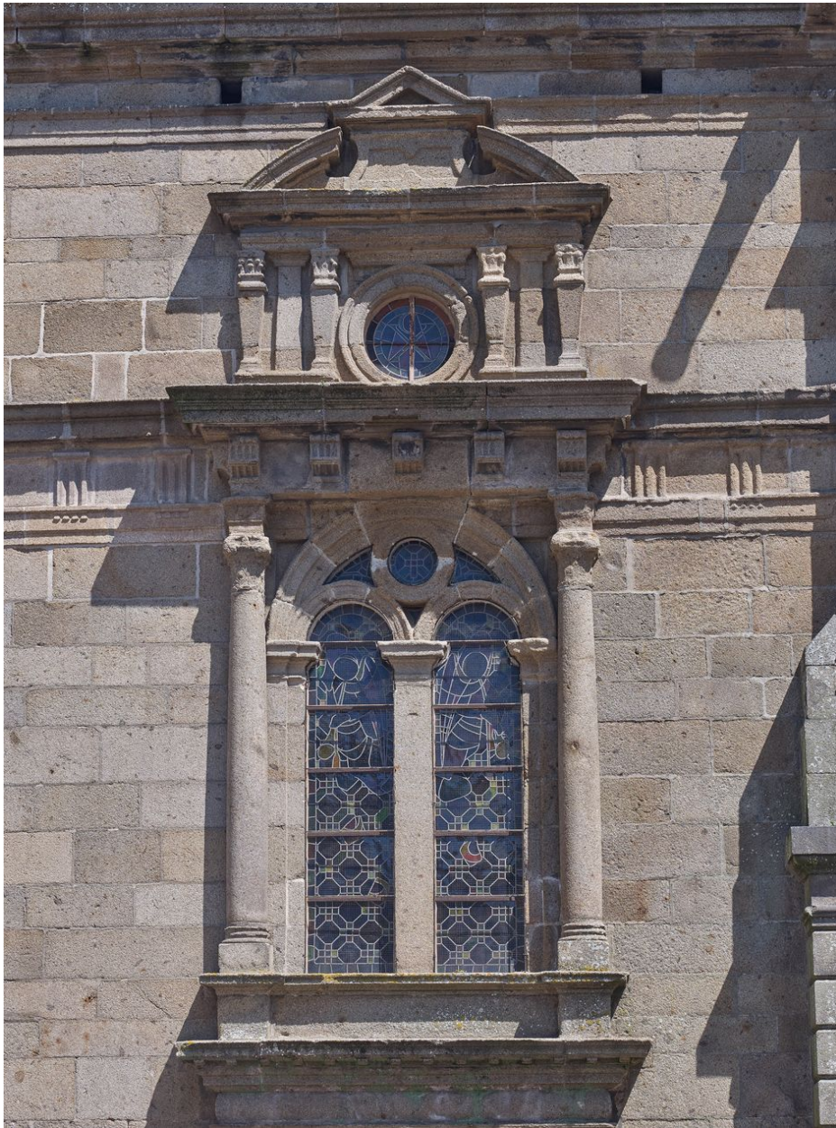
Façade occidentale, baie et détail du décor
