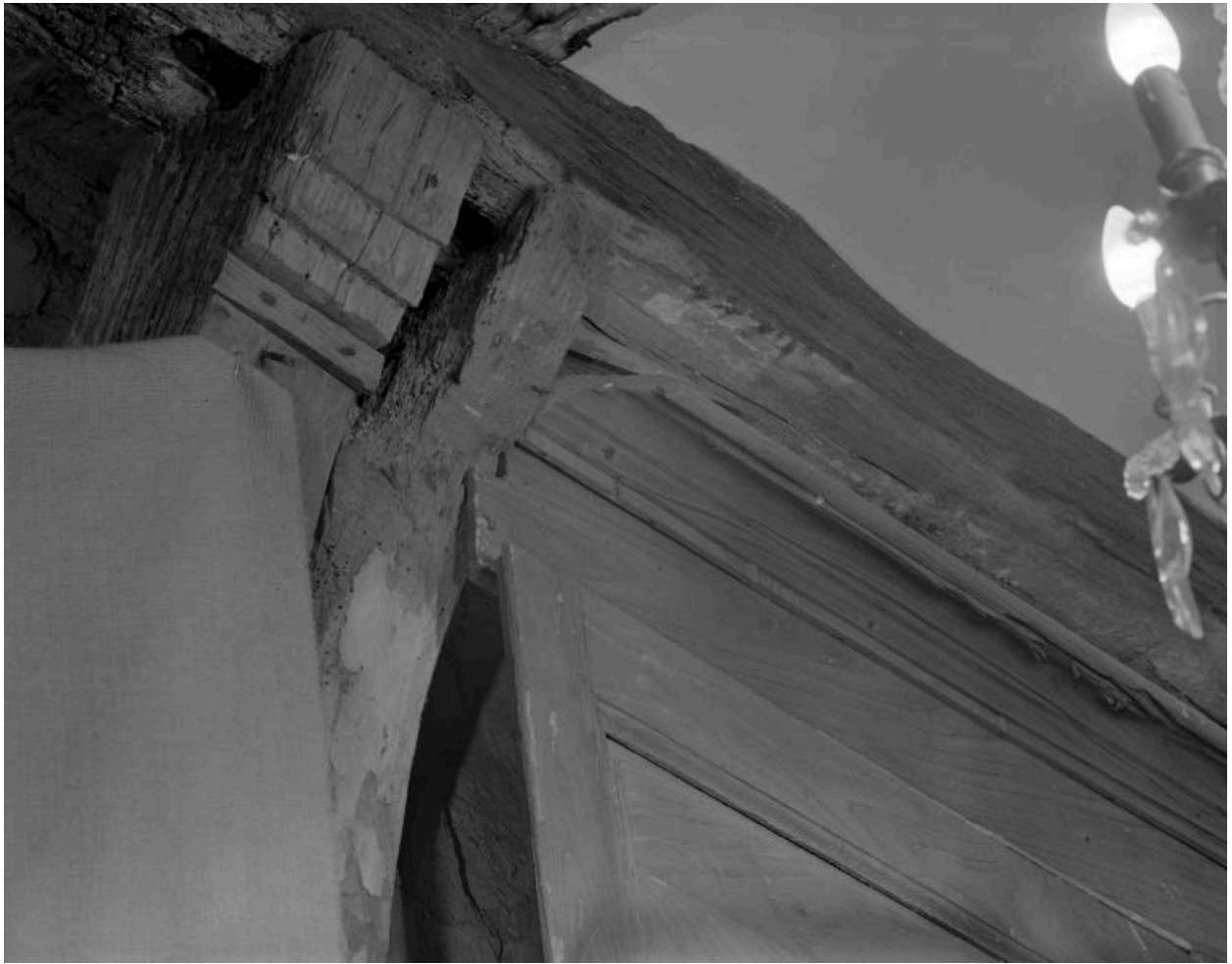
Vue intérieure, sablières, état vers 1980
