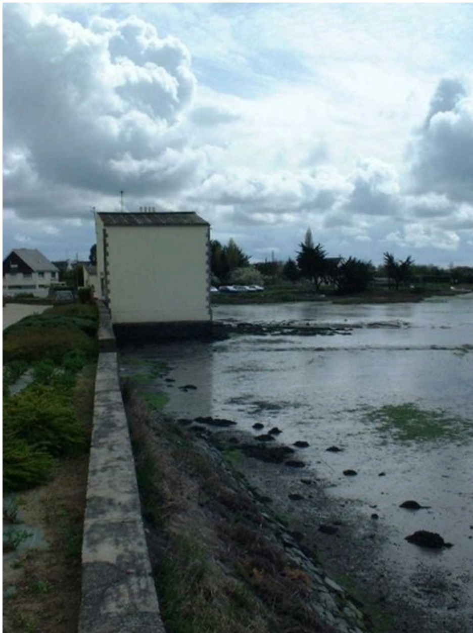
Moulin à marée de Cantizac, actuellement maison d'habitation
