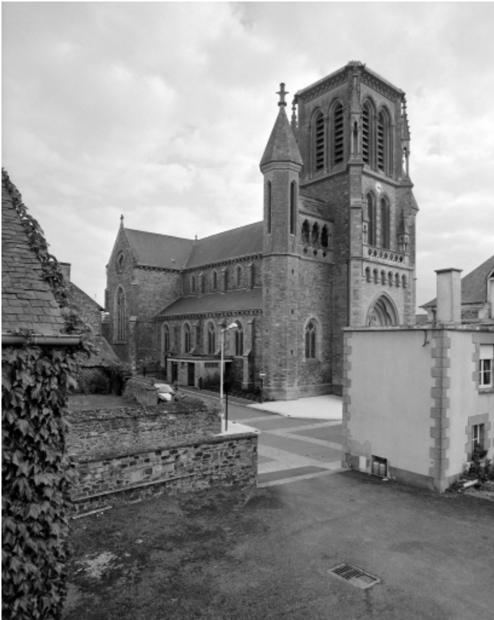
Elévation Nord-Ouest : vue générale
