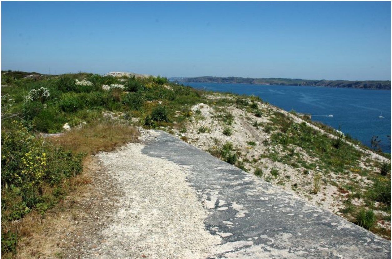
Vue de terrain environnant parsemé de cratères de bombe depuis la dalle de couverture de la cuisine et cantineVue de la cuisine et cantine en béton armé (état en 2005)
