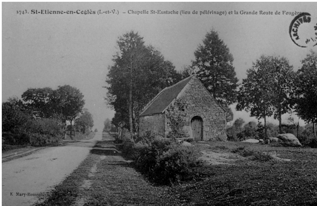
Élévation Ouest : vue de situation (Carte postale ancienne, AD35 : 6Fi)
