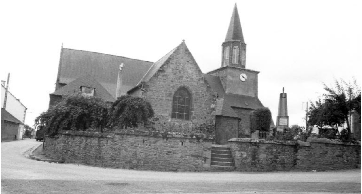
Vue d'ensemble de la façade nord
