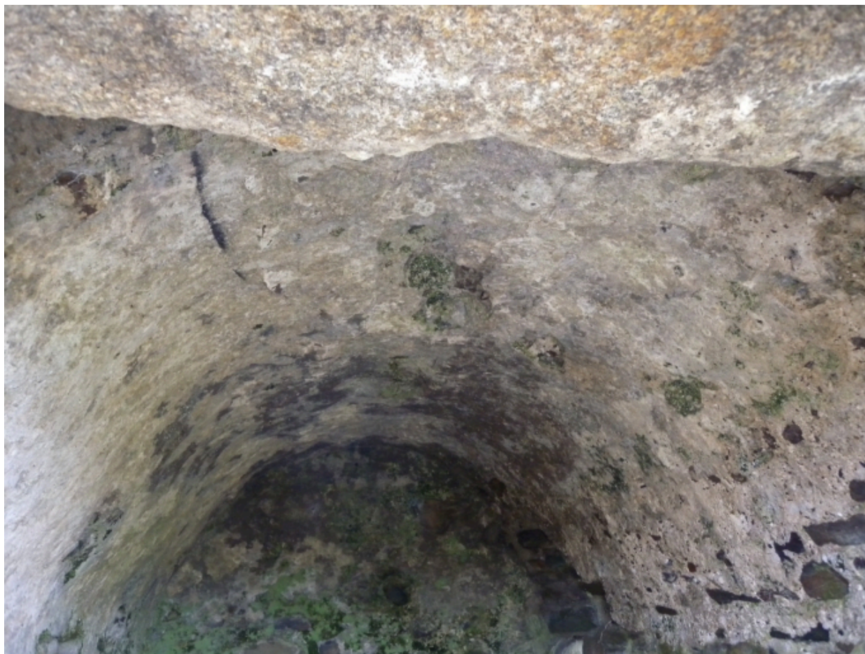
Vue de la voûte intérieure
