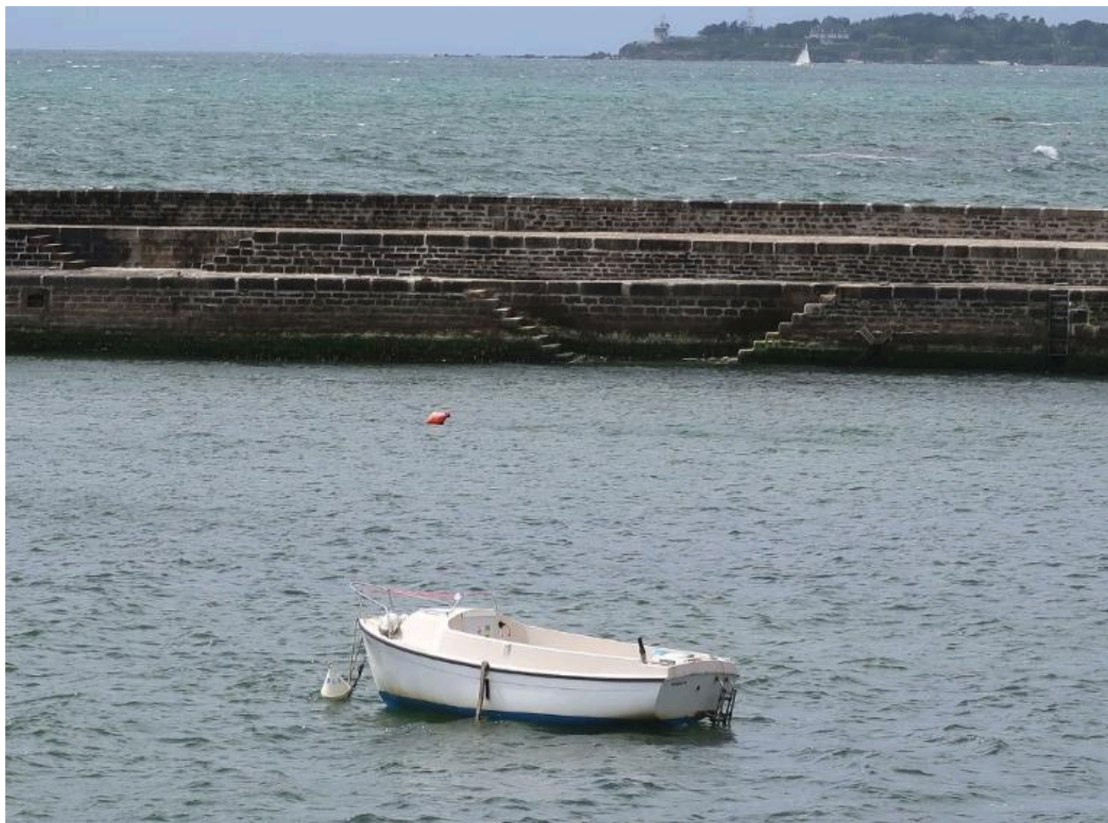
Môle de la Croix, escaliers et zone de mouillage
