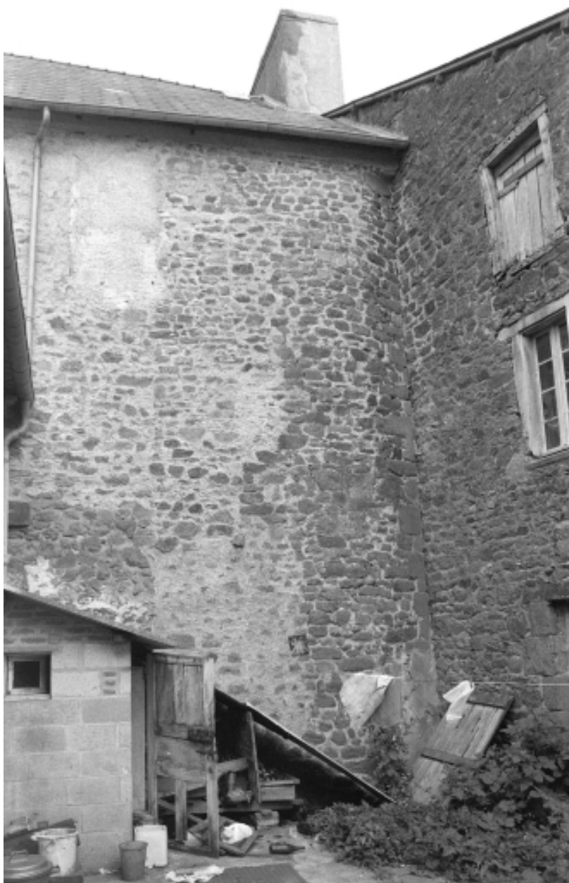
Vue de l'arrière du bâtiment en 1975
