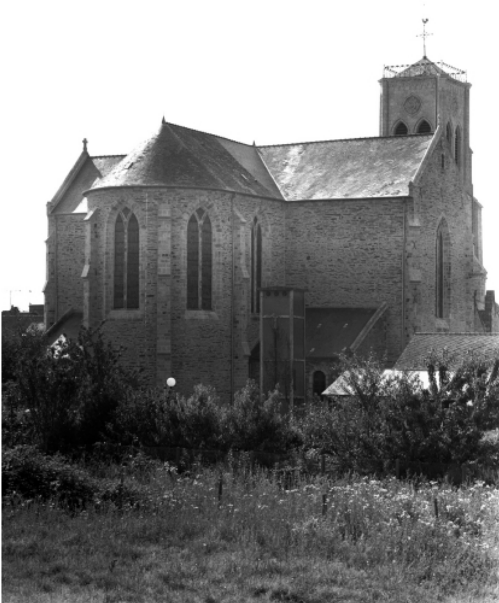
Le chevet : vue générale nord-ouest
