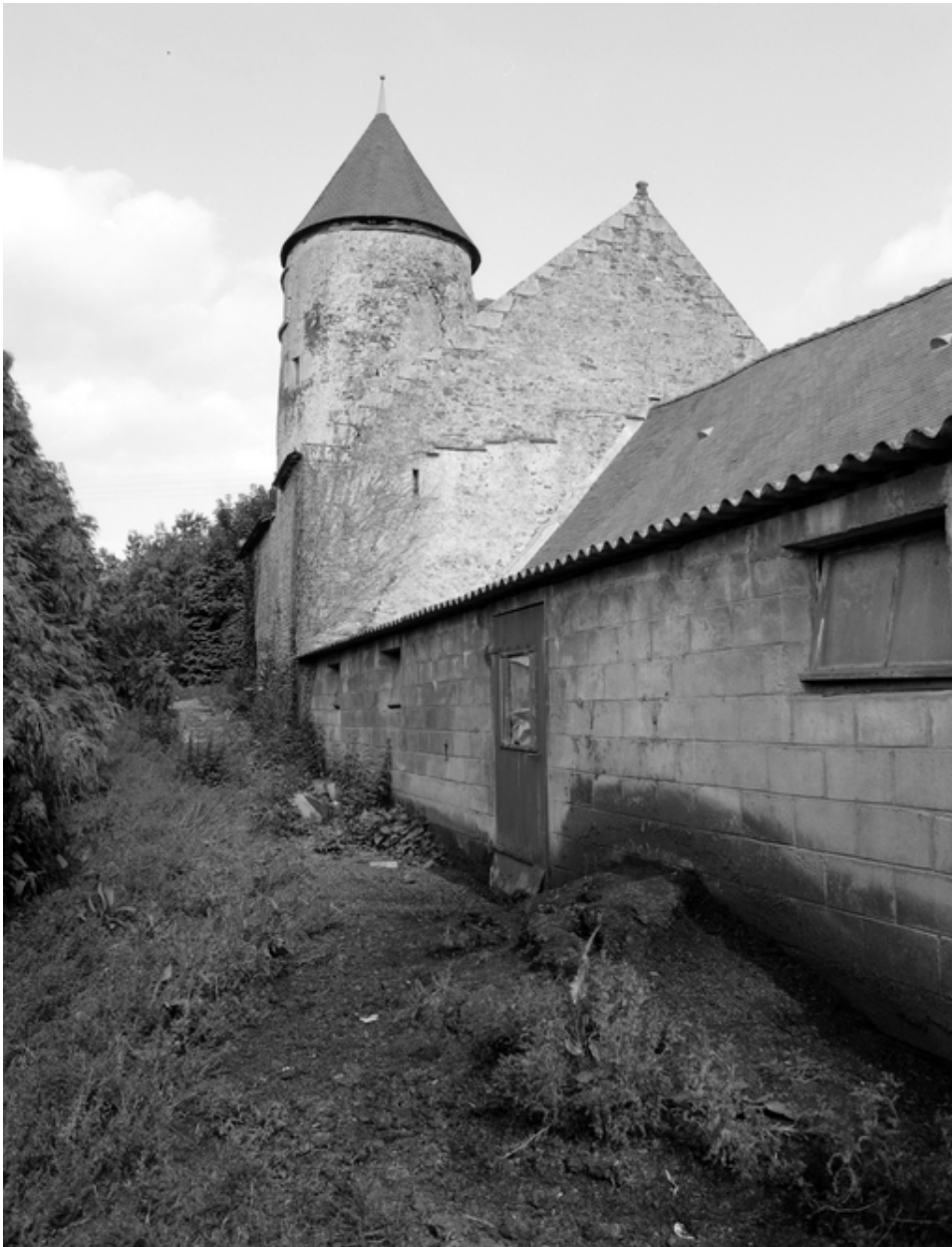
Vue générale de la façade postérieure.
