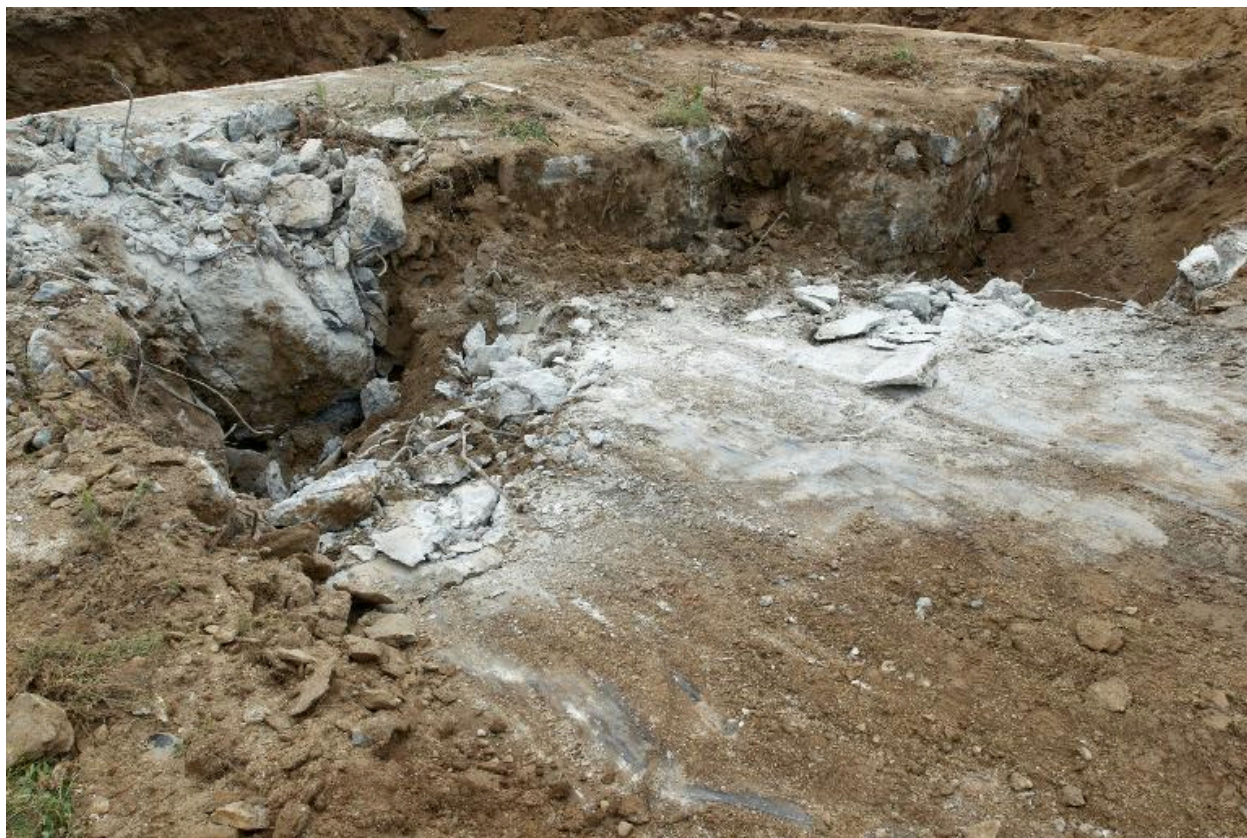
Déconstruction d'un bunker de type 502
