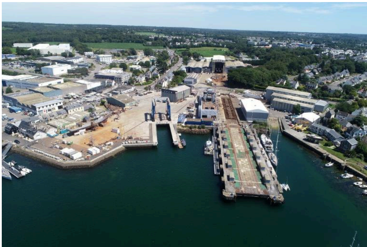
L'aire de réparation navale du port de Concarneau
