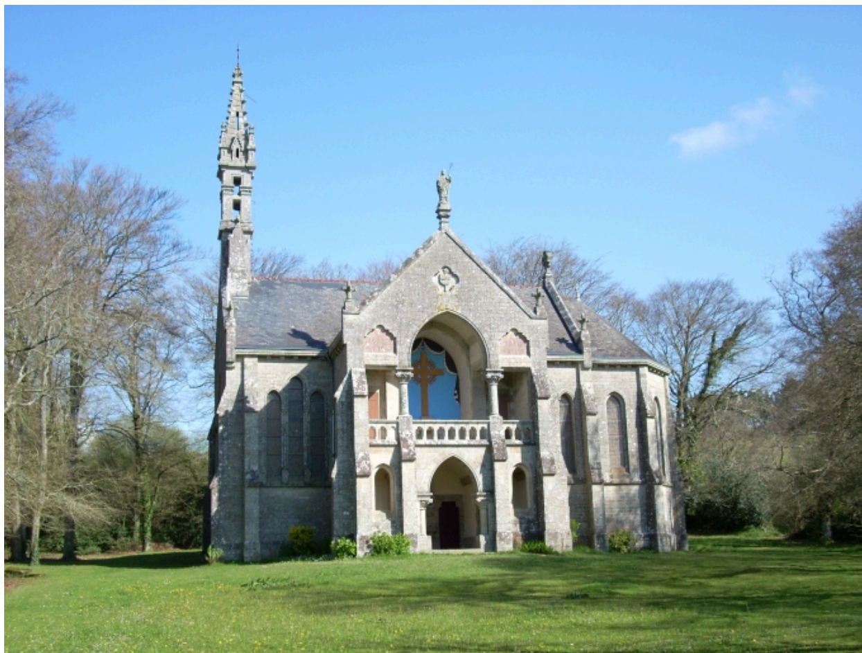
Plomodiern, chapelle Saint-Corentin : vue générale sud
