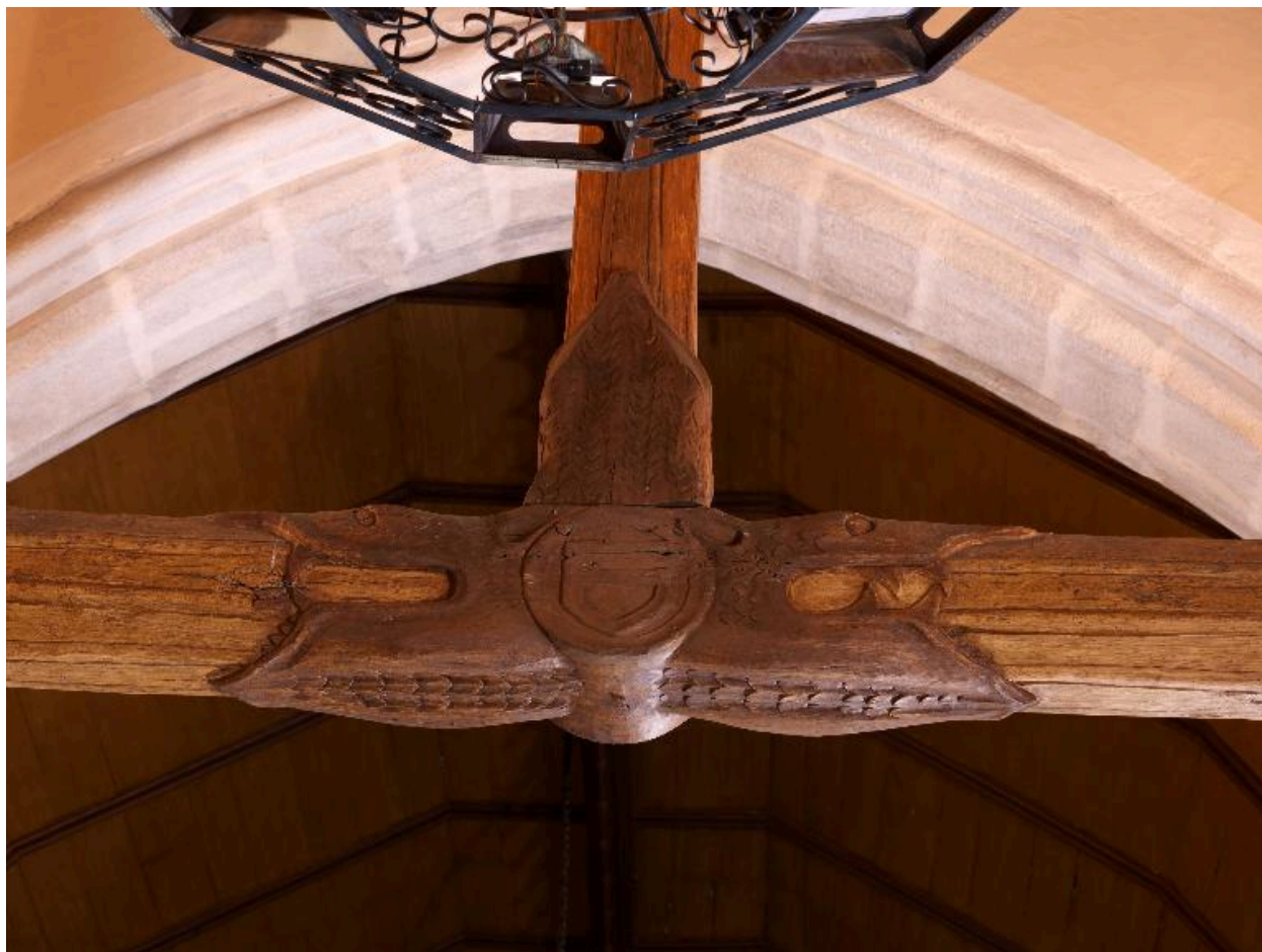
Engoulants de la charpente
