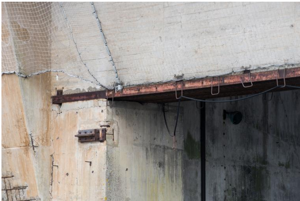
Vue de détail du front ouest orienté vers le Scorff : entrée de l'alvéole sud
