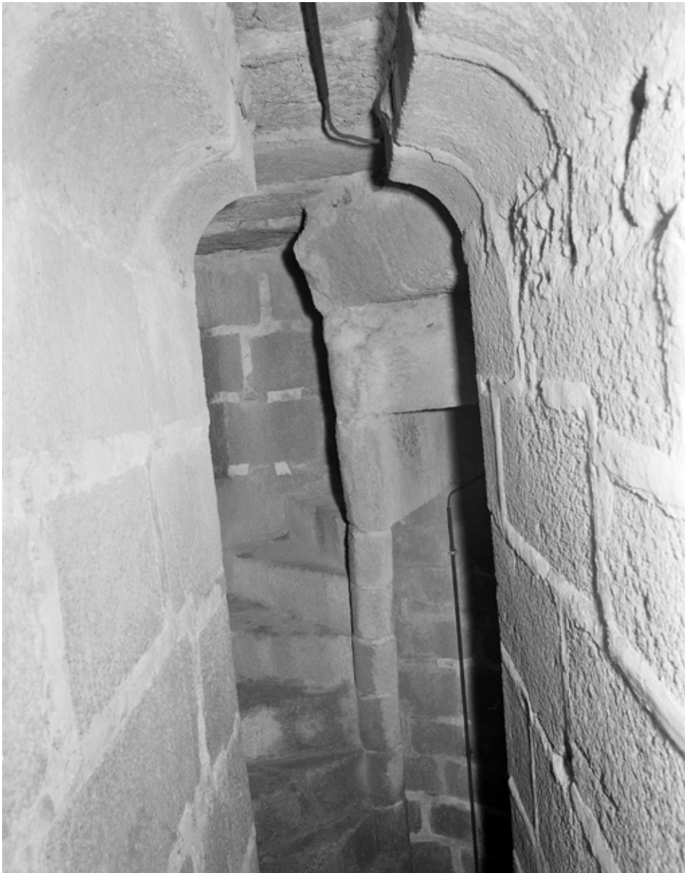
Tour occidentale, l'escalier
