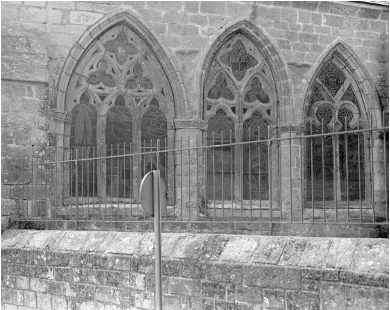
Choeur, chapelle sud, fenêtres est
